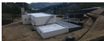
中継ポンプ施設全景
