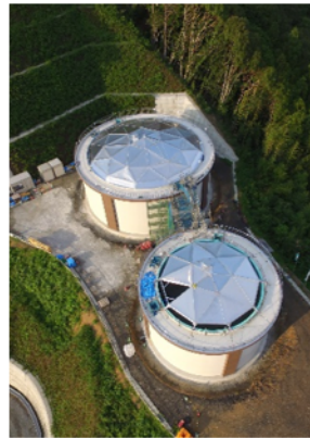
三里配水池整備状況
