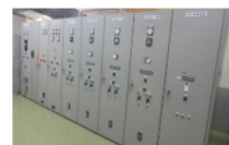
電気設備更新
