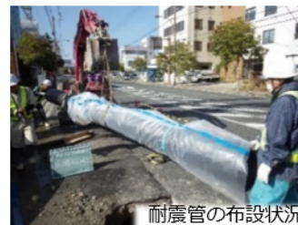
耐震管の布設状況
