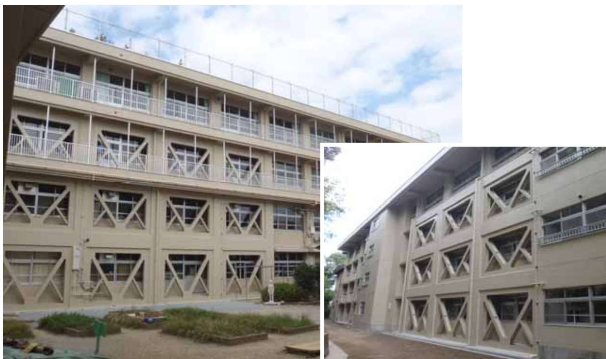
三里小学校北西舎耐震補強工事
