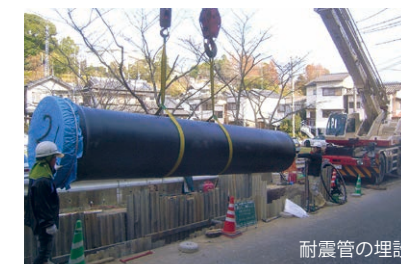
耐震管の埋設
