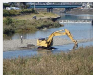
重機による整備
