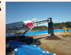
中間貯蔵施設 土壌貯蔵施設
