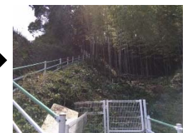
整備後の様子（ノツゴ山）
