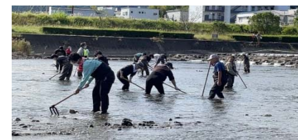
人力による手慣らしでの河床の整備の様子
