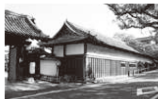
15 旧山内家下屋敷長屋展示館
