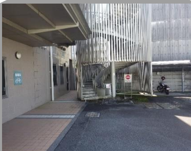
施設西側 体調不良者用 非常用階段
