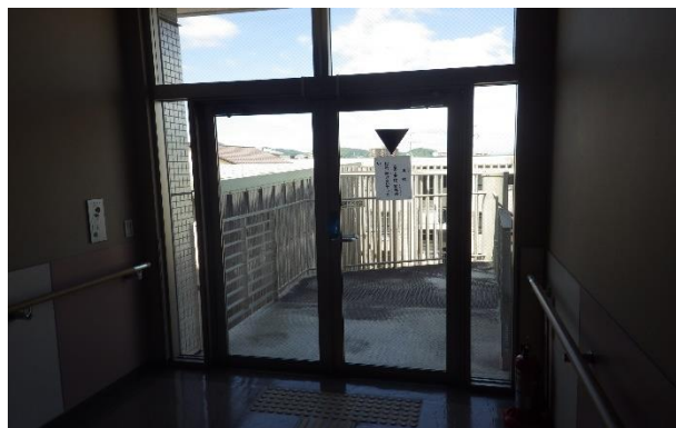
3階 西側出入口
