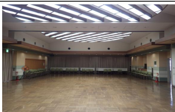
① 3階集会室：天井や照明の落下の確認
