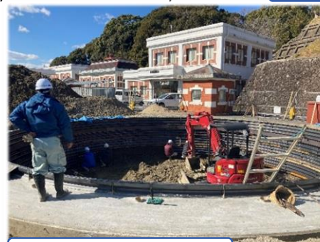
発進立坑築造状況（旭浄水場）
