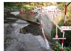
鏡115号線 路側欠損
