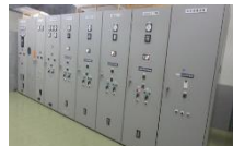
電気設備更新
