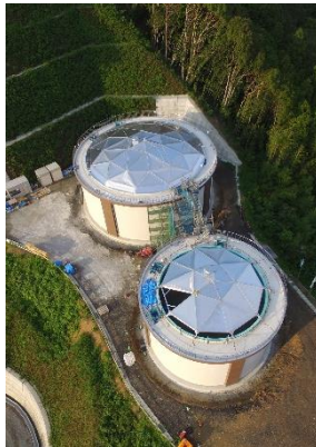
三里配水池整備状況
