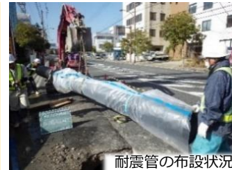
耐震管の布設状況
