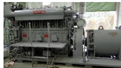
自家発電設備更新
