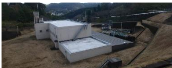
中継ポンプ施設全景
