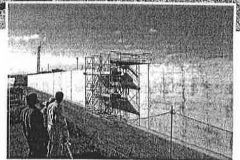
種崎地区の浦戸湾三重防護の防波堤現場
