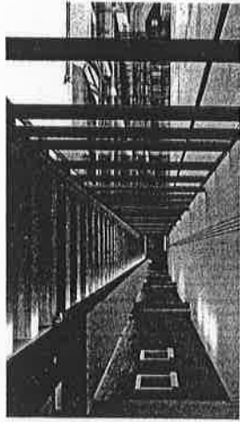
バルコニー下の通路は、透明ガラスの壁に包まれて、芸術的な良いプロムナードに生まれ変わった。 The previous balcony was now enclosed by a transparent glass screen and transformed into a pleasant lounge space.
