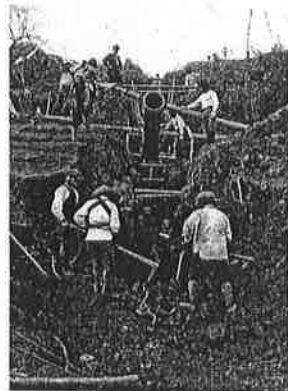
創設時の工事風景
