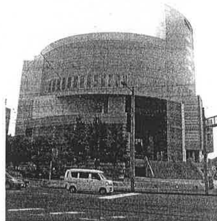
18年前、190億円で建設され今後115億円の修繕費が必要と示された「かるぼーと」
