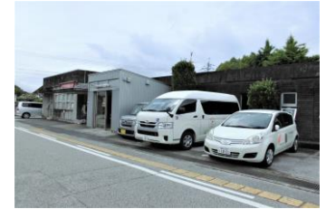
現在の施設の状況
