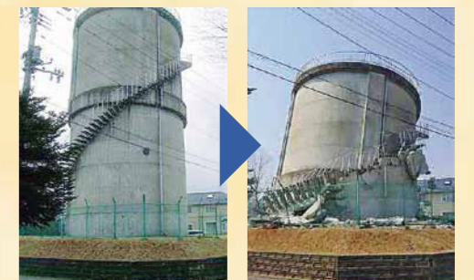
出典：平成23年(2011年)東日本大震災 水道施設被害等現地調査報告書
