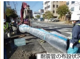
耐震管の布設状況
