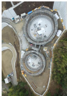
三里配水池整備状況
