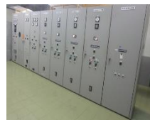
電気設備更新
