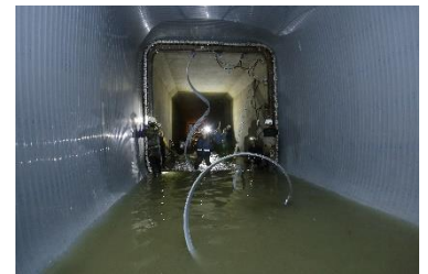
管渠の耐震化
