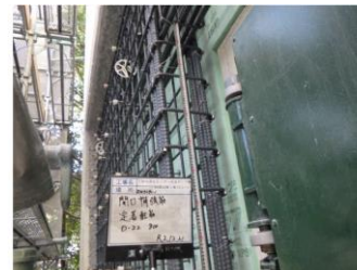
建物の耐震化
