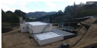
中継ポンプ施設全景
