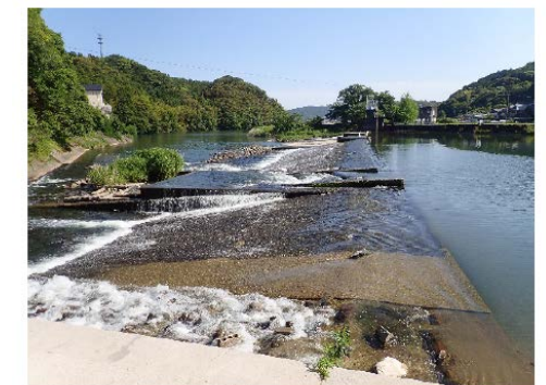
朝倉堰の現状(2018年5月)
