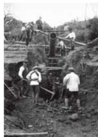
創設時の工事風景
