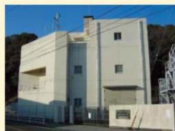
仁井田ポンプ場
