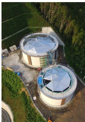
三里配水池整備状況
