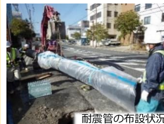
耐震管の布設状況
