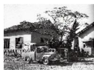
帯屋町の庁舎
