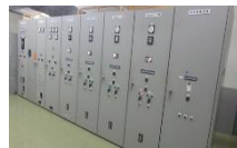
電気設備更新
