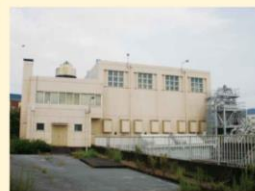
米田古川ポンプ場
