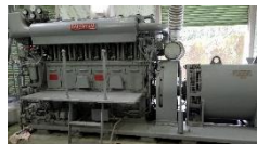
自家発電設備更新
