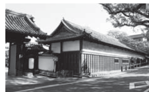
15 旧山内家下屋敷長屋展示館
