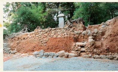
墓域九側から見た石垣
