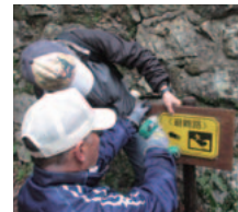
避難路誘導看板設置作業
