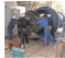
ポンプ整備状況
