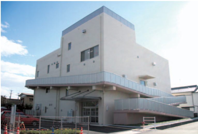
舟倉津波避難センター（仁井田）
