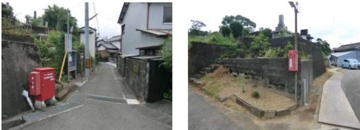
図 2-9 重点推進地区(旭東小学校区)内の消火器等の設置 例
