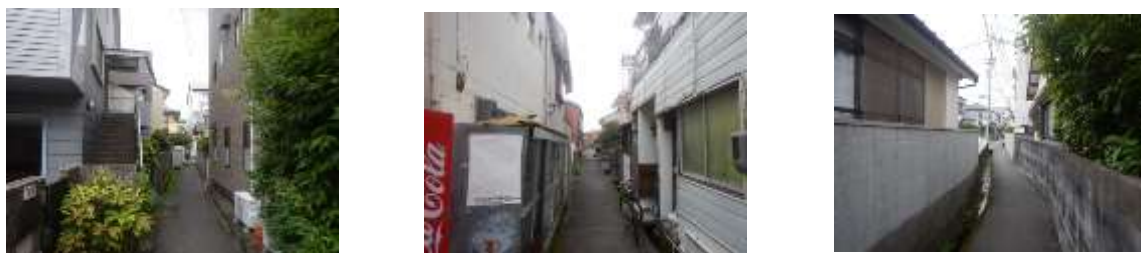
図 2-7 重点推進地区（小高坂小学校区）内の幅員の狭い道路の状況 例
