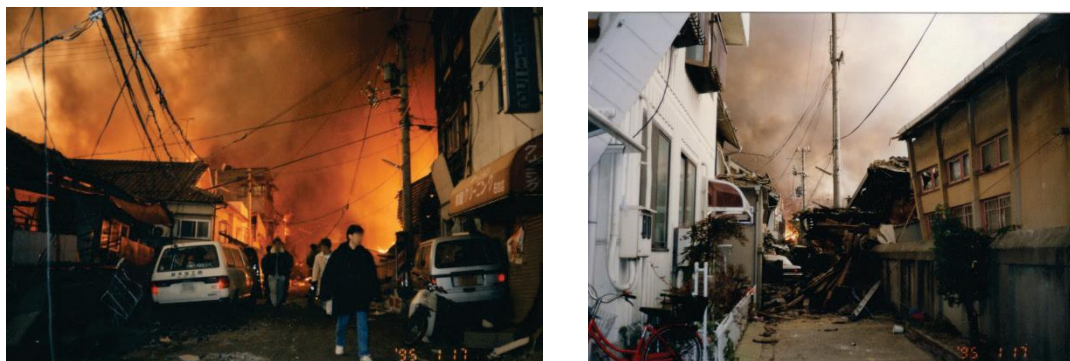
図3-2 阪神・淡路大震災における地震火災の被害
