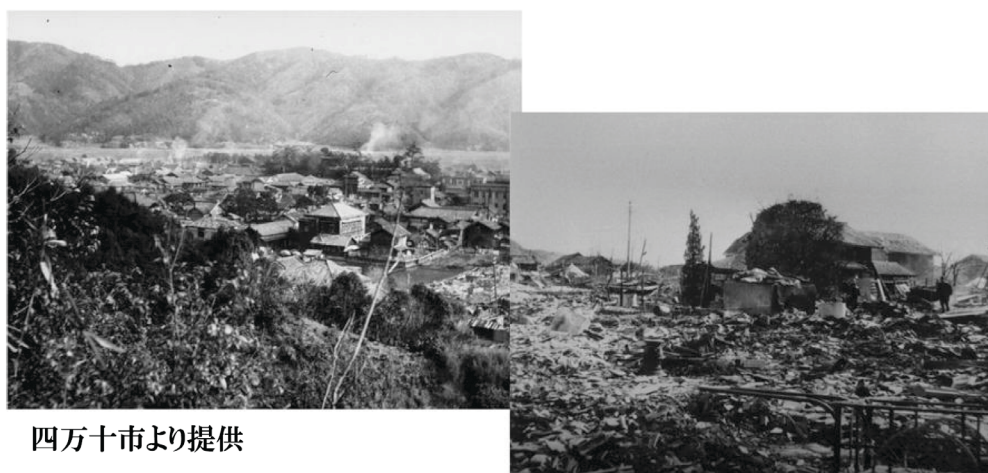
図3-1 昭和南海地震における高知県下の地震火災の被害(四万十市)
