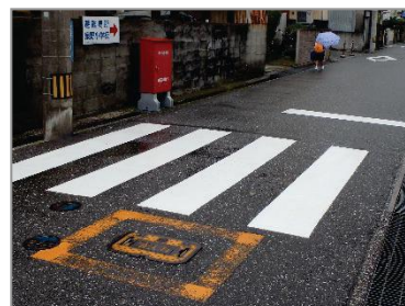
消火栓と消火栓ホースボックス(秦南町2丁目)
