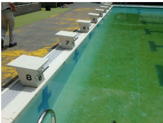
「短辺壁」にたわみが発生
