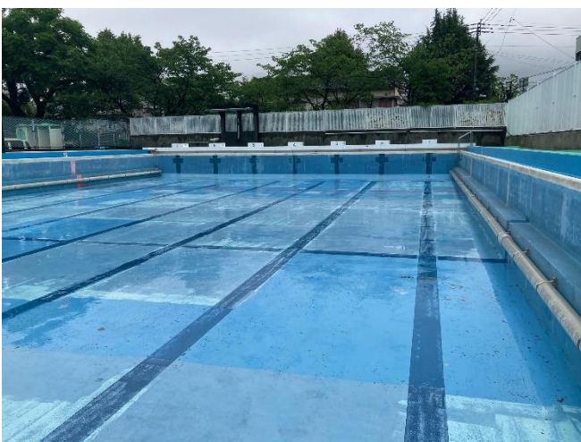
給水管 ※プールピットが無い ため、給水管が露出
