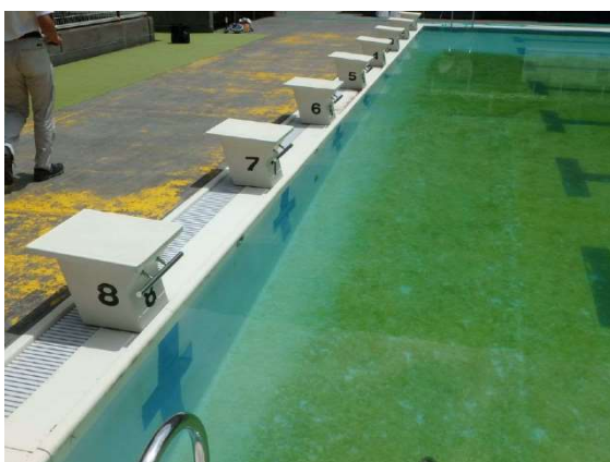
「短辺壁」にたわみが発生
