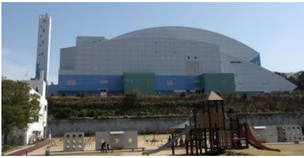
●ごみ焼却熱を活用しバイオマス発電を行う高知市清掃工場
