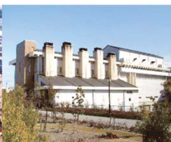
海老ノ丸ポンプ場
