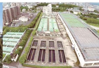
下知水再生センター
