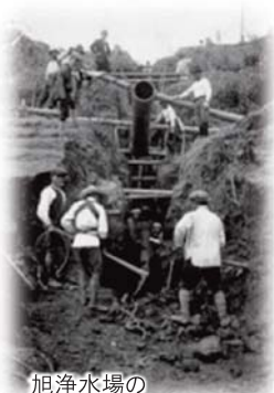
旭浄水場の送水管理設工事(大正13年)
