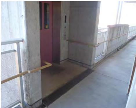
エレベーターホール
