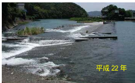
流量が豊富な調査時における朝倉堰の流況
