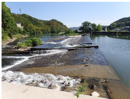
朝倉堰の現状(2018 年 5 月)
