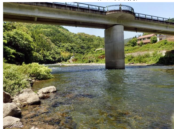
St. 17 (札幌ノ下橋)
