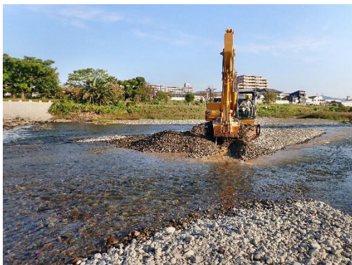
近年産卵場が安定的に形成されるトリム堰下流(上)とそこでの河床整備状況(下)
