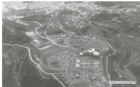
針木浄水場の建設状況(昭和50年代)
