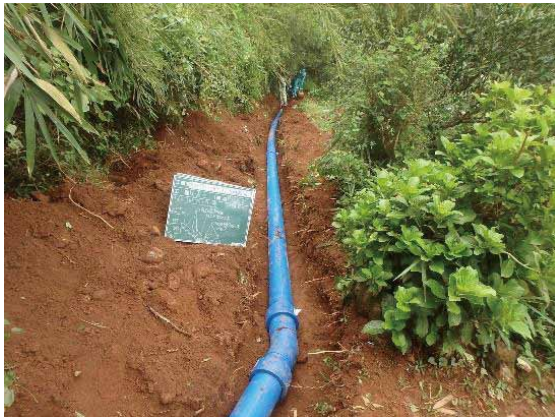
急勾配な法面施工
