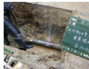
老朽管の漏水状況
