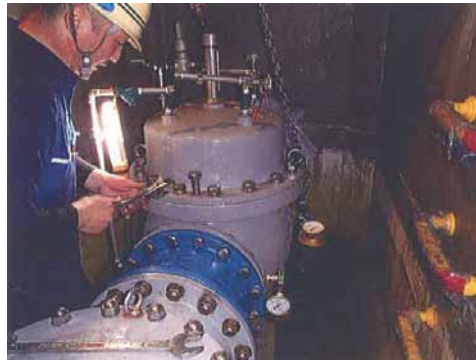
減圧弁の清掃・再調整状況
