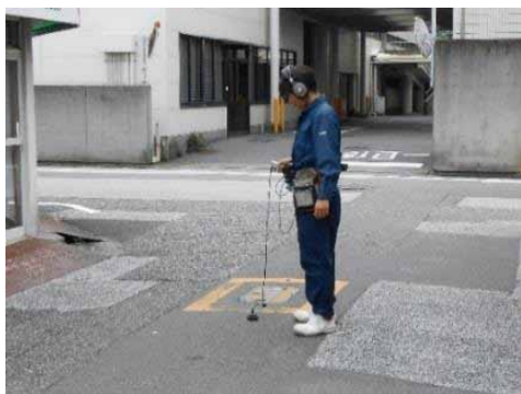
漏水調査状況
