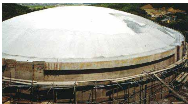
大津配水池の建設状況(昭和50年代)
