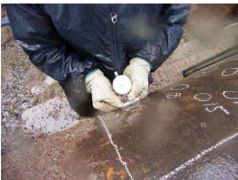
管体調査による老朽度判定
