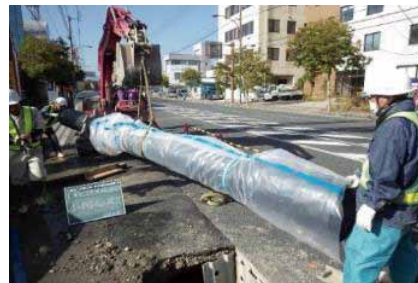
地震の揺れでも抜け出さない耐震管
