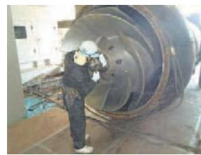
部品交換などによる長寿命化対策
