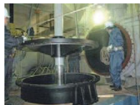
排水ポンプ軸受けの取替
