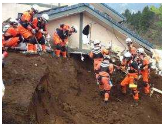
熊本地震現場活動の様子
