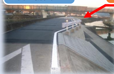
五台山防災道路
