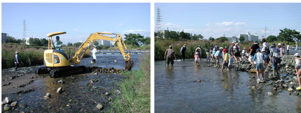
（トリム公園床止下流）での産卵場造成作業の状況
