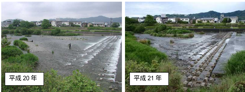
平成 20 年と 21 年調査時におけるトリム公園床止の状況
