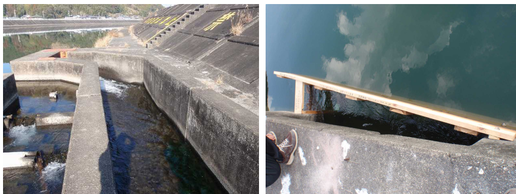
江の口用水（左）と取水口に設置された迷入防止装置（右）
