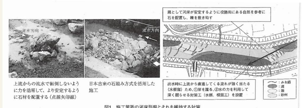
図1 施工箇所の河床形態とそれを維持する対策
