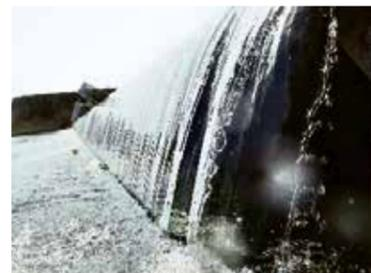
廓中堰ゲート倒伏時に生じた水面落差
