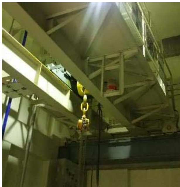
No. 59 と誤って認識していた天井走行クレーン
