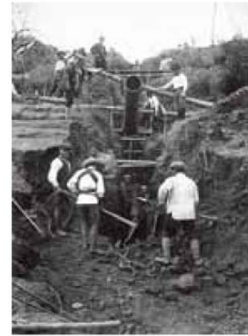
創設時の工事風景
