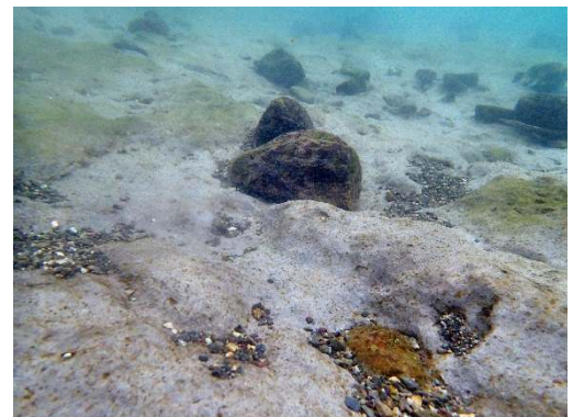
トリム堰下流の河床に露頭した粘土層
