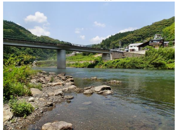
St. 17 (札場ノ下橋)
