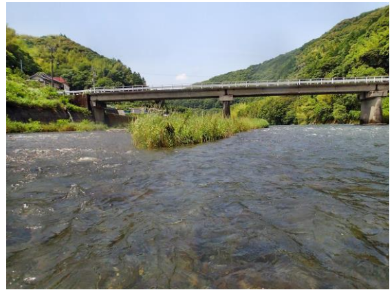
St. 15 (大河内橋)
