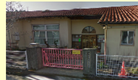
耐震補強予定の愛善保育園
