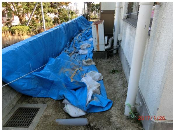
管理棟の玄関前にできた地割れ。日が経つにつれて段々広がってきているとのこと（左）。建物は写真の左側を走る道路より高い位置にあり、擁壁が大きく左に傾き、ビニールシートで覆われていますが地割れもでき、配管もむき出しになっています（右）。建物自体は基礎がしっかりしているので、傾いたりはしていないということでした。
