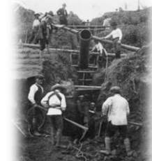
旭浄水場の送水管埋設工事(大正13年)
