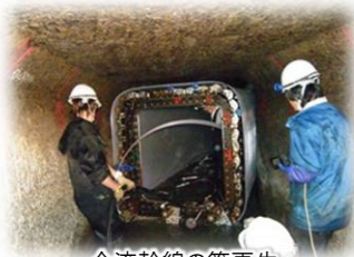
合流幹線の管更生
