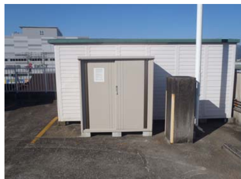
資機材保管庫
