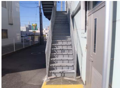
事務所棟外階段
