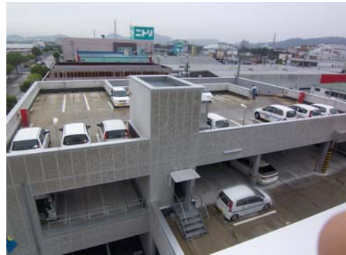
駐車場棟屋上
