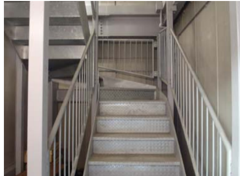
駐車場棟階段
