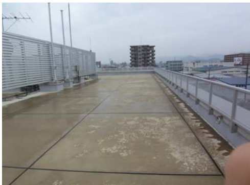
事務所棟屋上
