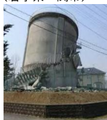
地震による配水池倒壊 (岩手県一関市) 出典: 東日本大震災水道施設被害等現地調査団報告書より(H23年9月)
