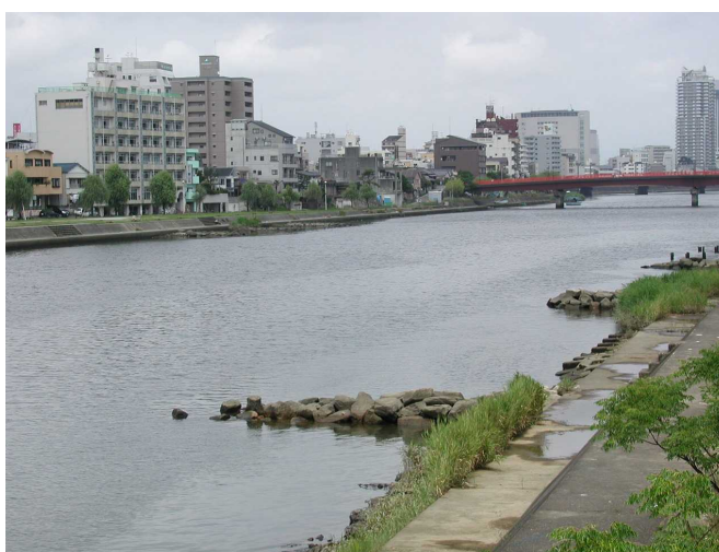
柳原橋下流右岸に設置された水刳（水制工）（平成 8 年度施工）
